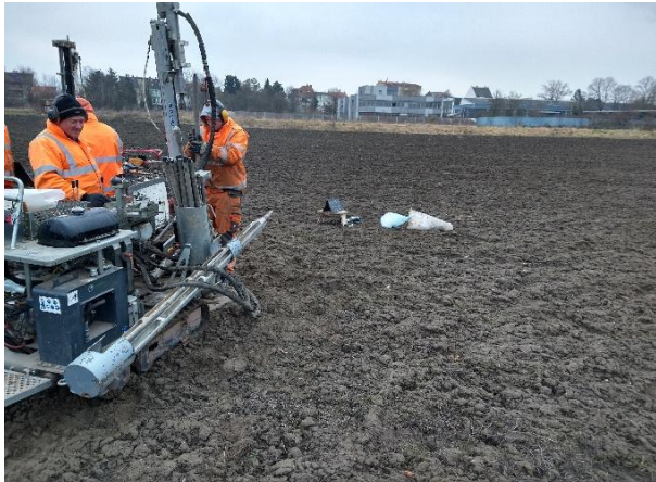
Abb. 1: Exmpl. Ansicht Erkundungspunkt KRB 1
