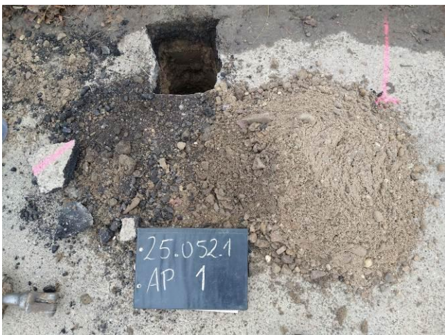
Bild 3: Ludwigshafen, NBG Frankenthaler Straße, SCH 1, Detailsicht: Schurf
